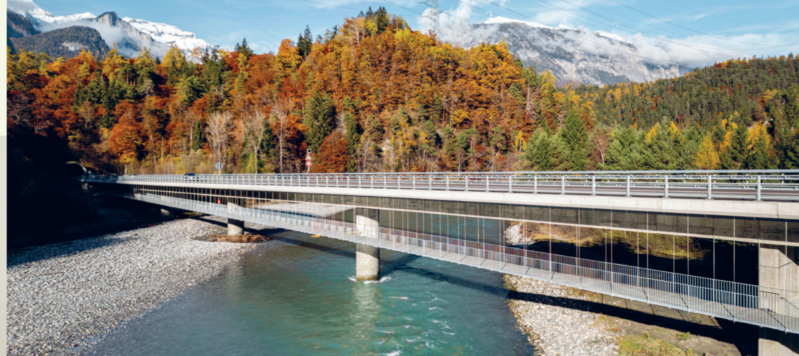
Mit dem 326,5 Meter langen Brückensteg schufen die Gemeinden Domat/Ems und Bonaduz eine Fussgänger- und Veloverbindung über den Hinterrhein. Die filigrane Stahlkonstruktion des Bauingenieurbüros Konzett, Bronzini & Partner hängt unter der verbreiterten Autobahnbrücke.
